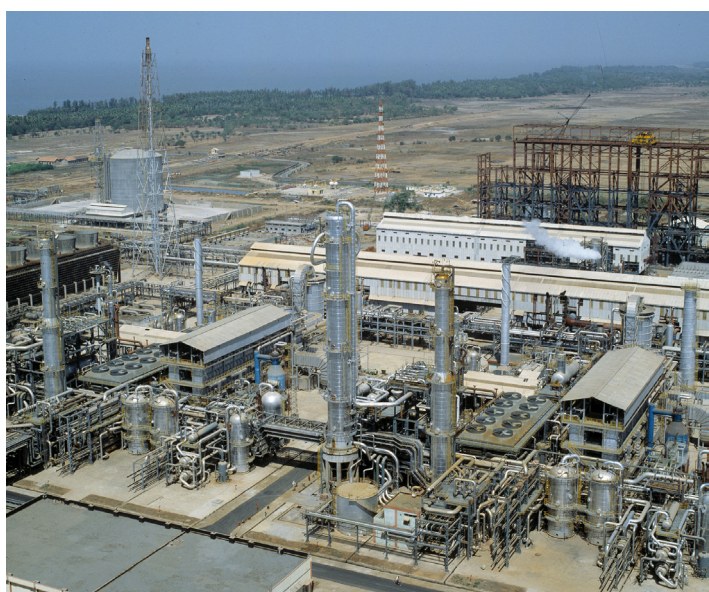
Et indisk ammoniak anlæg der kan producere 3000 tons ammoniak om dagen.
